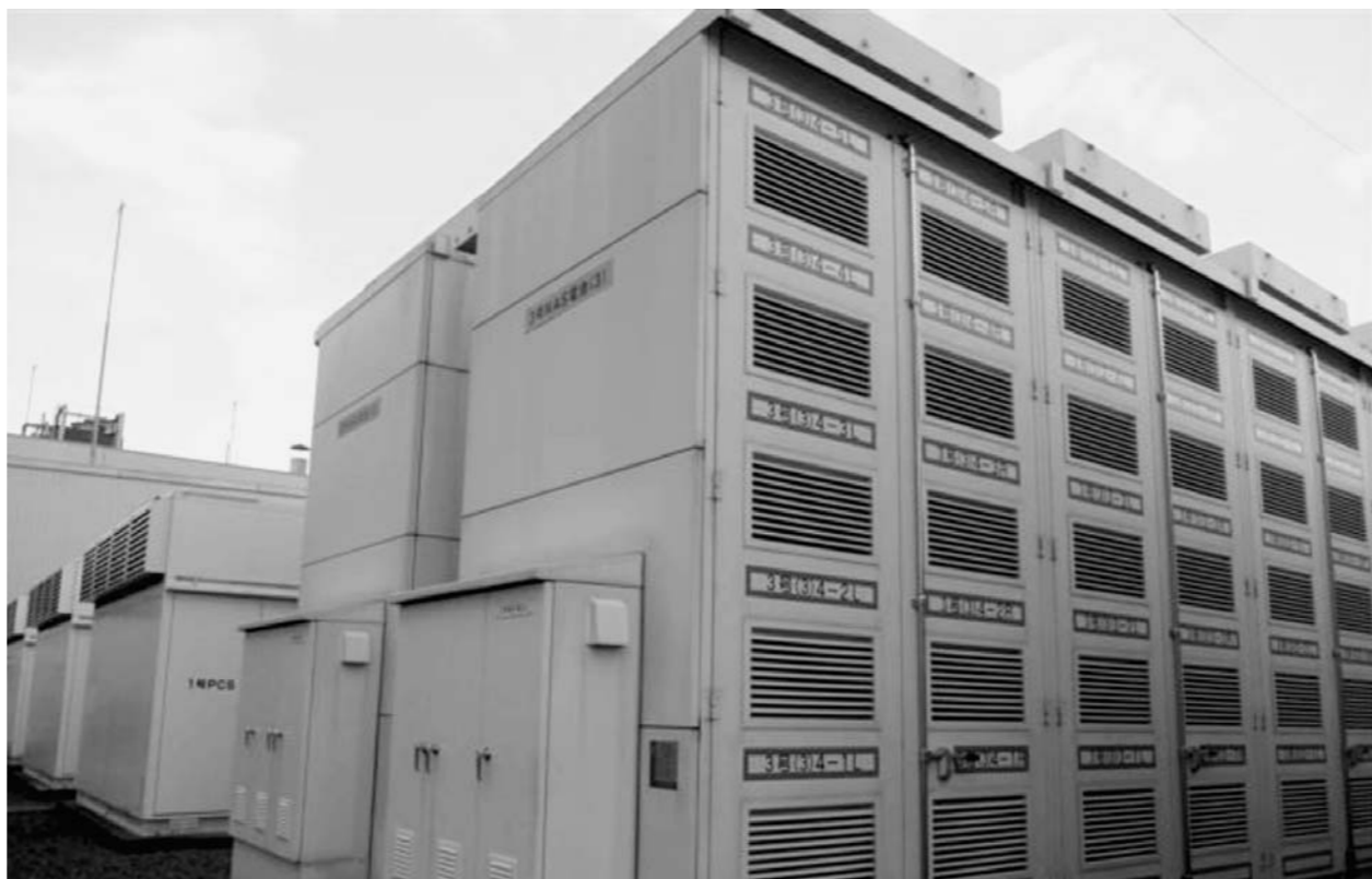
一般家庭300世帯の1カ月分の電力を購入するNAS電池(本田技研四輪R&Dセンター)
