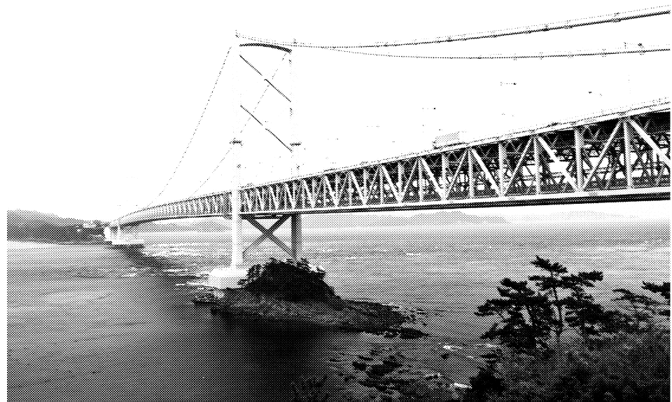
大鳴門橋(徳島県鳴門市から撮影)
