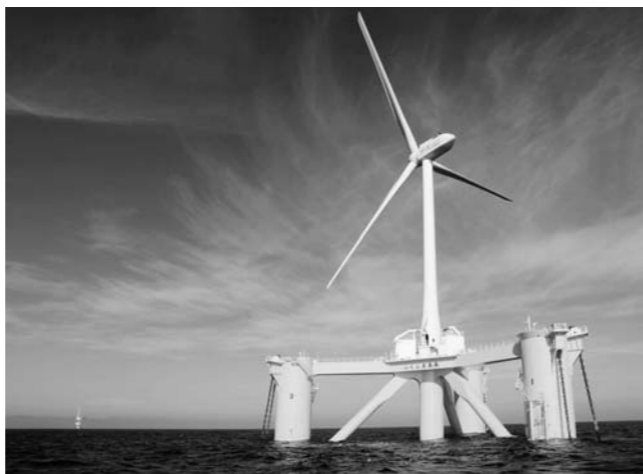
図1 福島沖の2.5MW浮体式洋上風車(日立製作所製。提供・Toru NAGAO)
