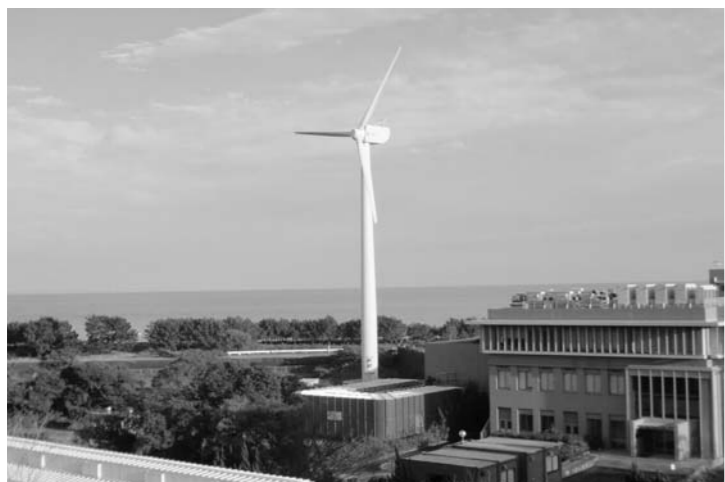
図4 三重大学スマートキャンパス実証事業で発電中の300kW風車(駒井ハルテック製)
