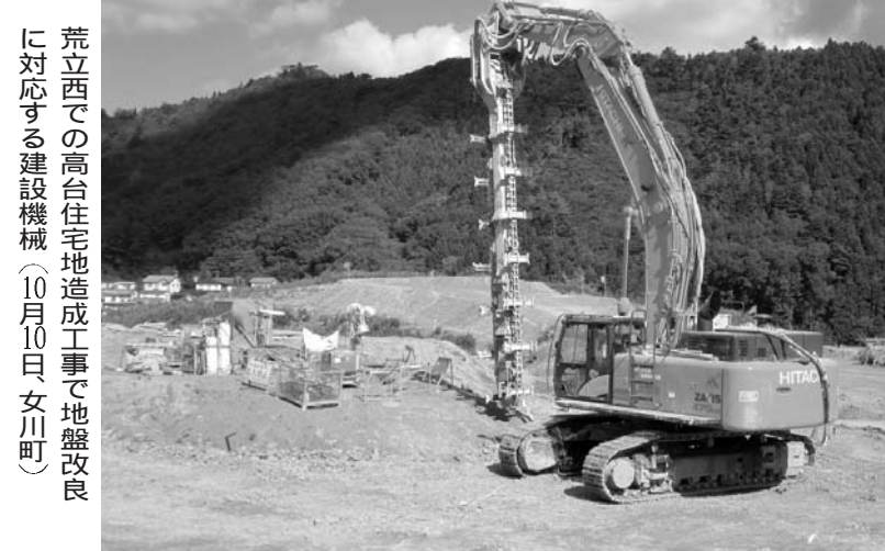
荒立西での高台住宅地造成工事で地盤改良に対応する建設機械(10月10日、女川町)
