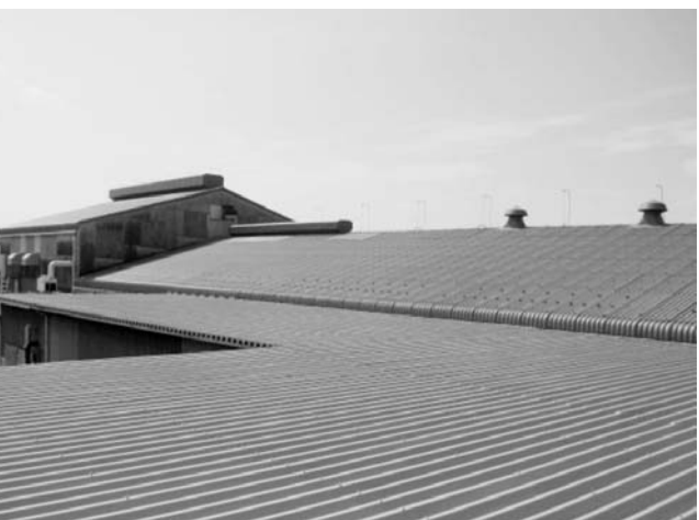
遮熱塗料を屋根に塗装することで省エネルギーなどを実現（JSR提供）
