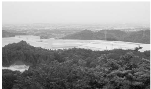
ホンダ寄居工場
