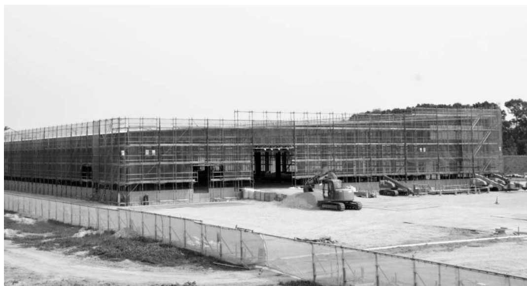
建設が進む伊藤ハムの新工場（取手市）
