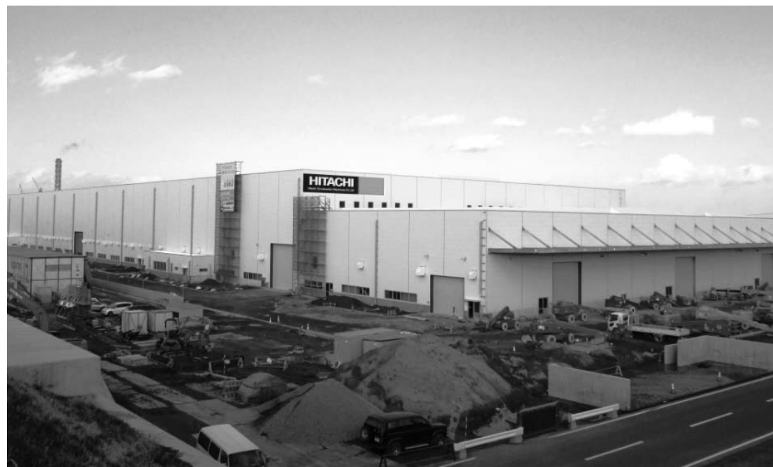
日立建機が港湾用地に建設した新工場
