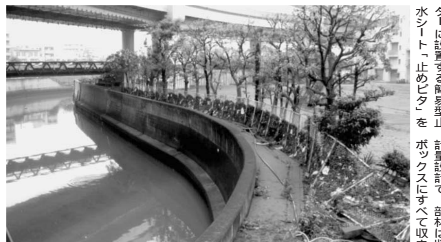
水位の急激な上昇はフェンス、樹木まで倒す
