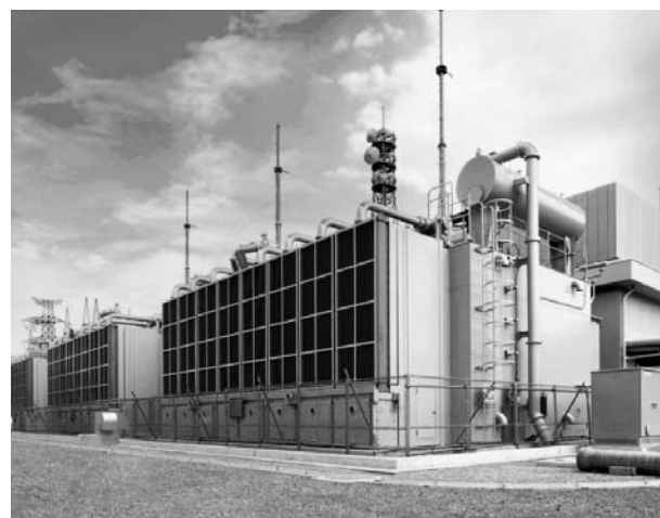
世界最大級のスタットコム。電力を長距離にわたって安定的に送れる
