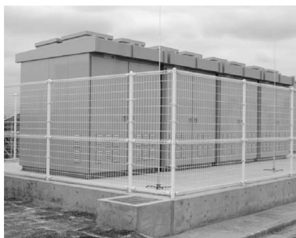
パワーコンディショナー収納盤 (埼玉・行田浄水場)
