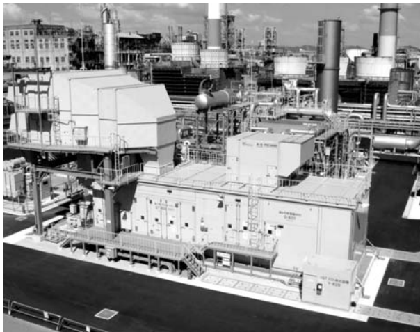
「L30A」によるコージェネレーションプラント(川崎重工工業提供)
