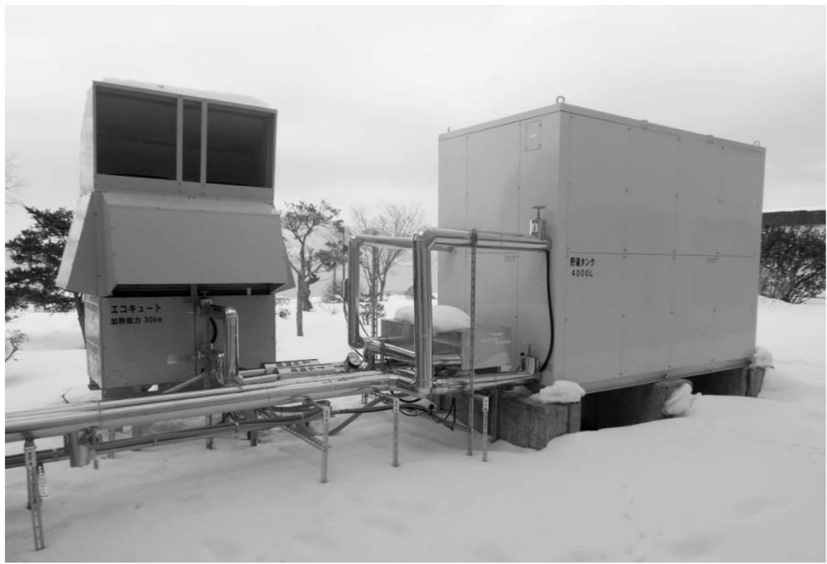
北海道の温泉施設に設置した三菱重工のキュートン
