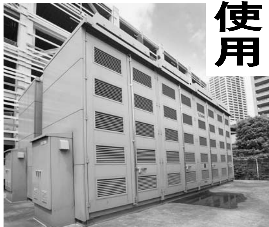
柏の葉スマートシティに隣接する商業施設に設置された蓄電池
