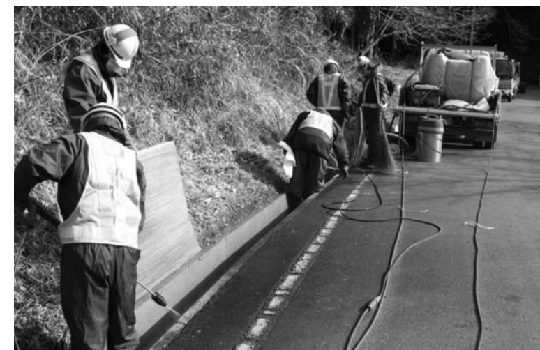
福島県南相馬市が高倉地区で行っている道路の除染作業
