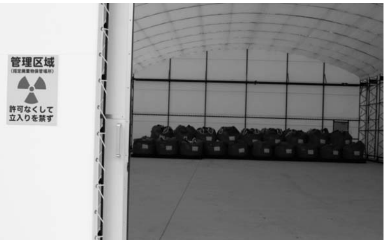
一般産業物の焼却灰などの一時保管施設(千葉県印西市)
