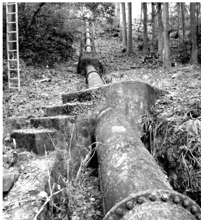
須雲川発電所の再開発では既存の水圧鉄管を活用
