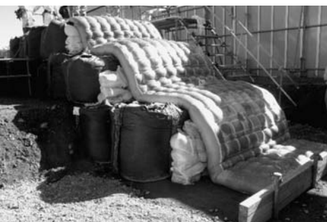
「ベントスロープF工法」で布製型枠に遮水材を充填した状態(大林組)
