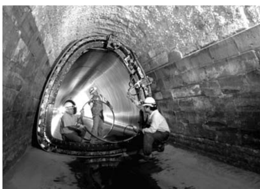
海外事業の拡大を目指す積水化学の管路更生工法「S-PR工法」
