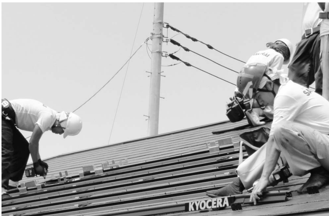
京セラなど国内4社のシステムはPID現象による出力低下が認められなかった
