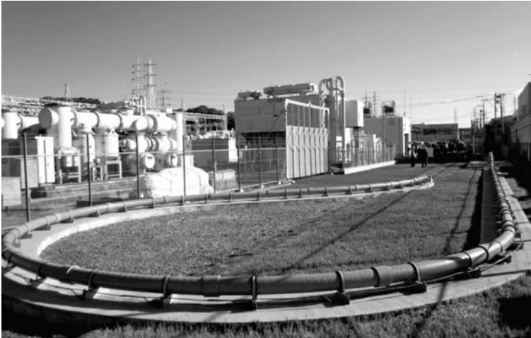
東京電力旭変電所に設置された実証試験用の超電導ケーブル
