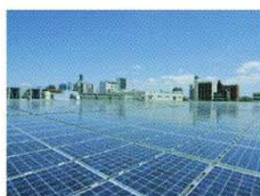
太陽光発電システム 屋上に設置された約1,800枚の 太陽光パネルが工場全体で 使用する電力の約15%をカバー。 電力 削減量 -355,400kwh ※発電による使用電力削減効果
