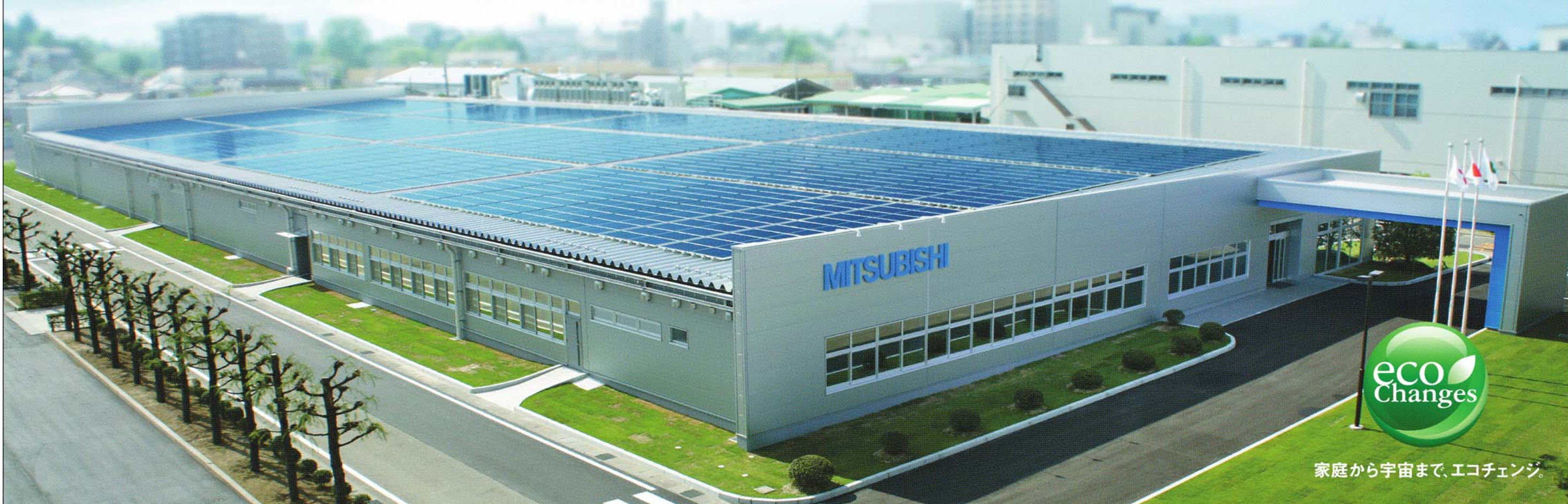
太陽光発電システム 屋上に設置された約1,800枚の 太陽光パネルが工場全体で 使用する電力の約15%をカバー。 電力 削減量 -355,400kwh ※発電による使用電力削減効果
