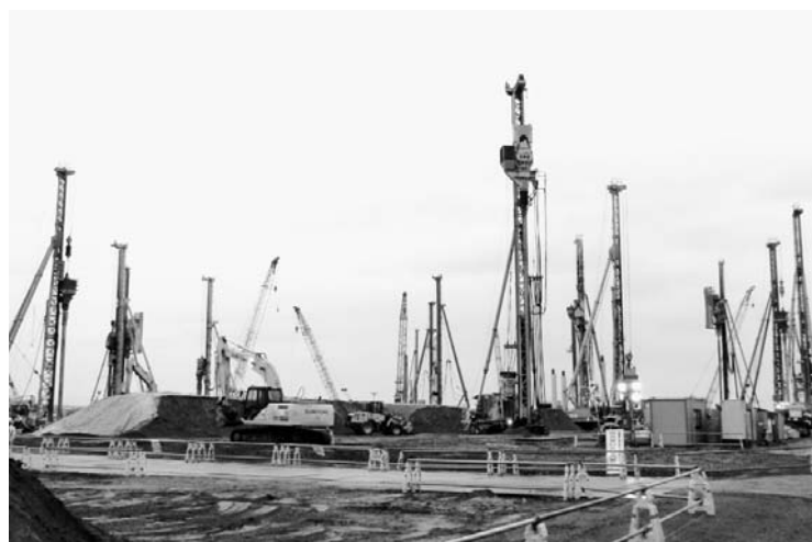
建設が進む東京ガスの「日立LNG基地」
