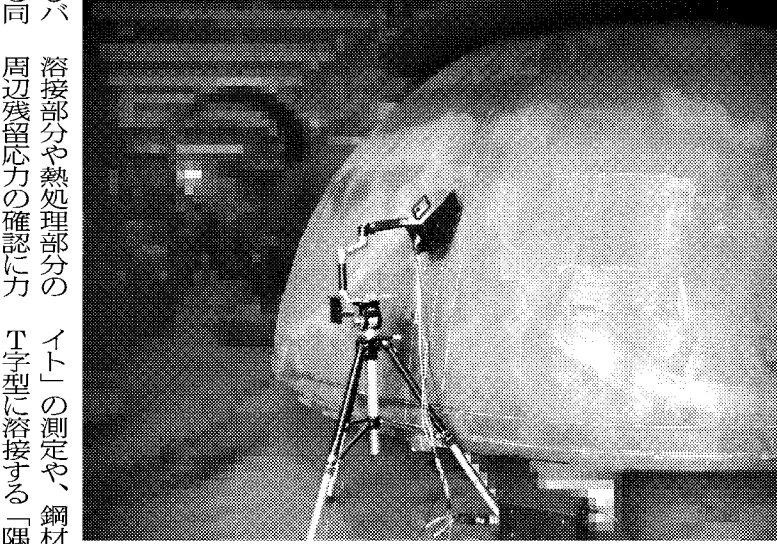
「μ-X360」を現場に持ち込み、タンク表面の残留応力を計測
