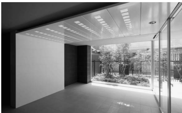
三菱化学の有機ELパネルを採用したエントランスホール
