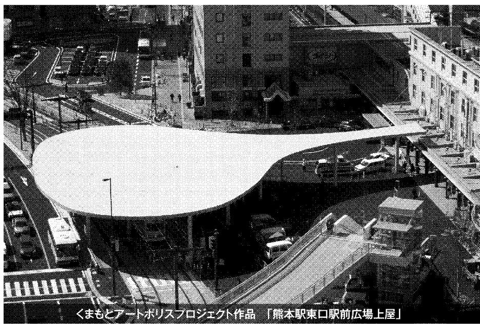
くまもとアートポリスプロジェクト作品「熊本駅東口駅前広場上屋」
