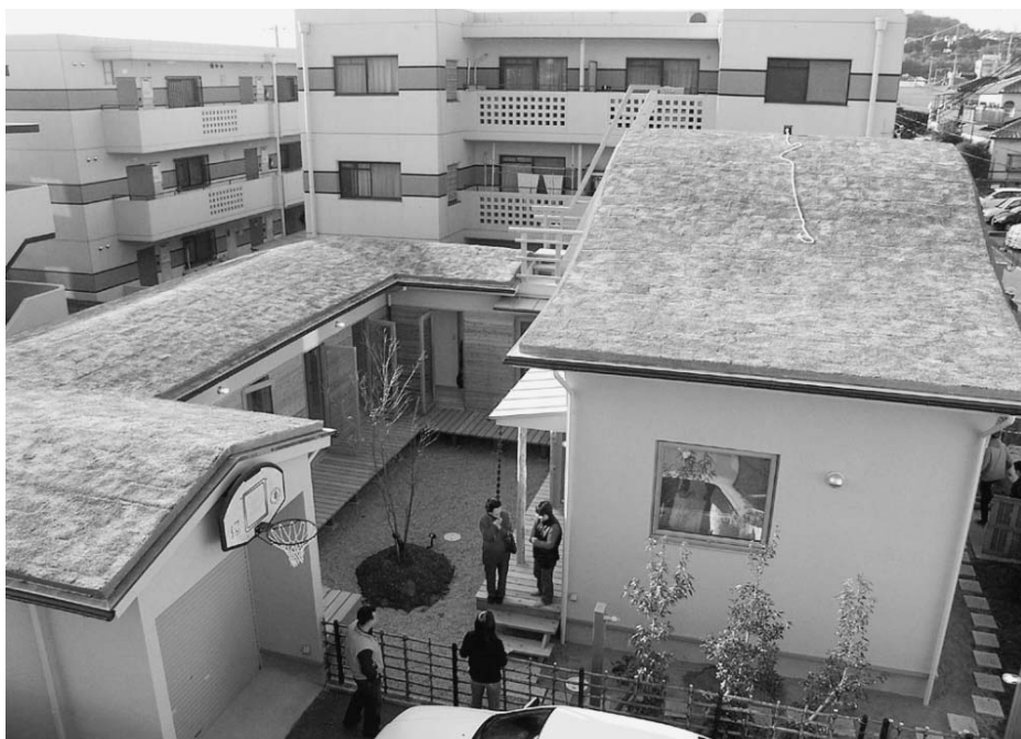
写真1 木造草屋根住宅は夏涼しく、屋根に上ってくつろいだり植物を育てたりもできる
