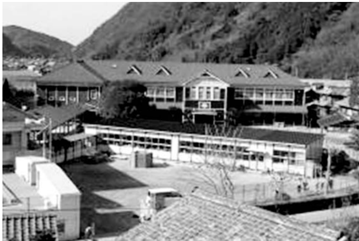
愛媛・伊予市立翠小学校の木造エコ改修（09年改修）
