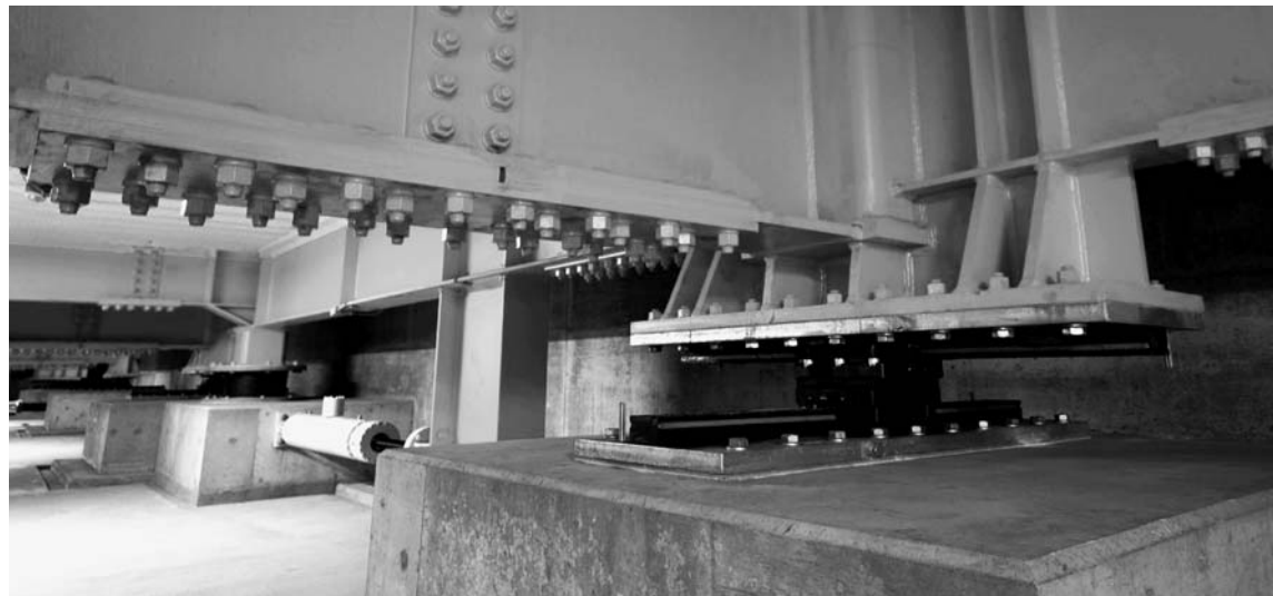
THK防震システム (直道転がり支承・粘性減衰装置)
