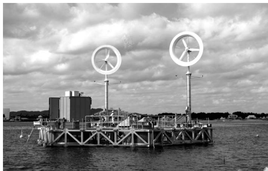
九州大学が実験を行う風レンズ風車
