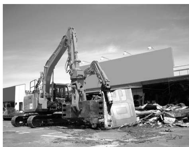
宮城県石巻市で被災した冷凍庫コンテナを撤去する双腕作業機(日立建機提供)
