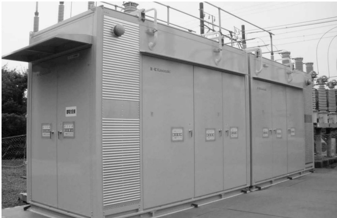
東急電鉄「つきみ野変電所」に設置した地上蓄電設備
