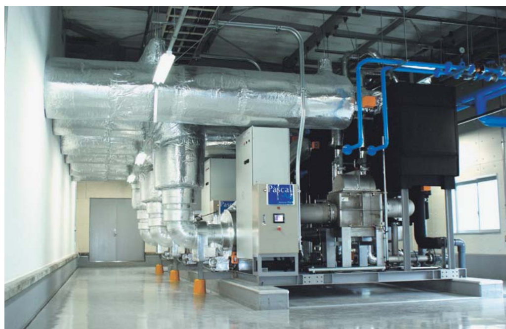
空気を冷媒に活用した前川製作所の冷凍システム。電力使用量を3割削減できる
