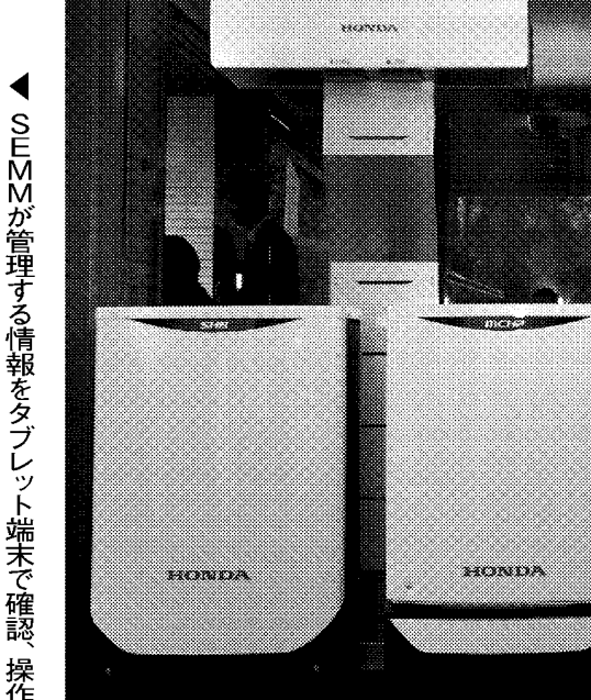
▲ HSHS機器 (上から時計回り: Smart e Mix Manager、給湯器、ガスエンジンコジェネレーションユニット、蓄電池)
