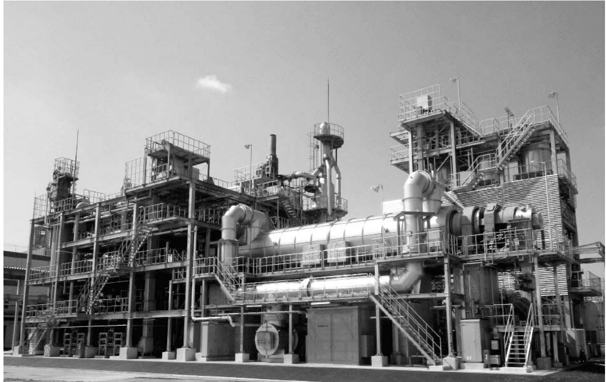
下水汚泥を火力発電の燃料にする設備（中部電力）
