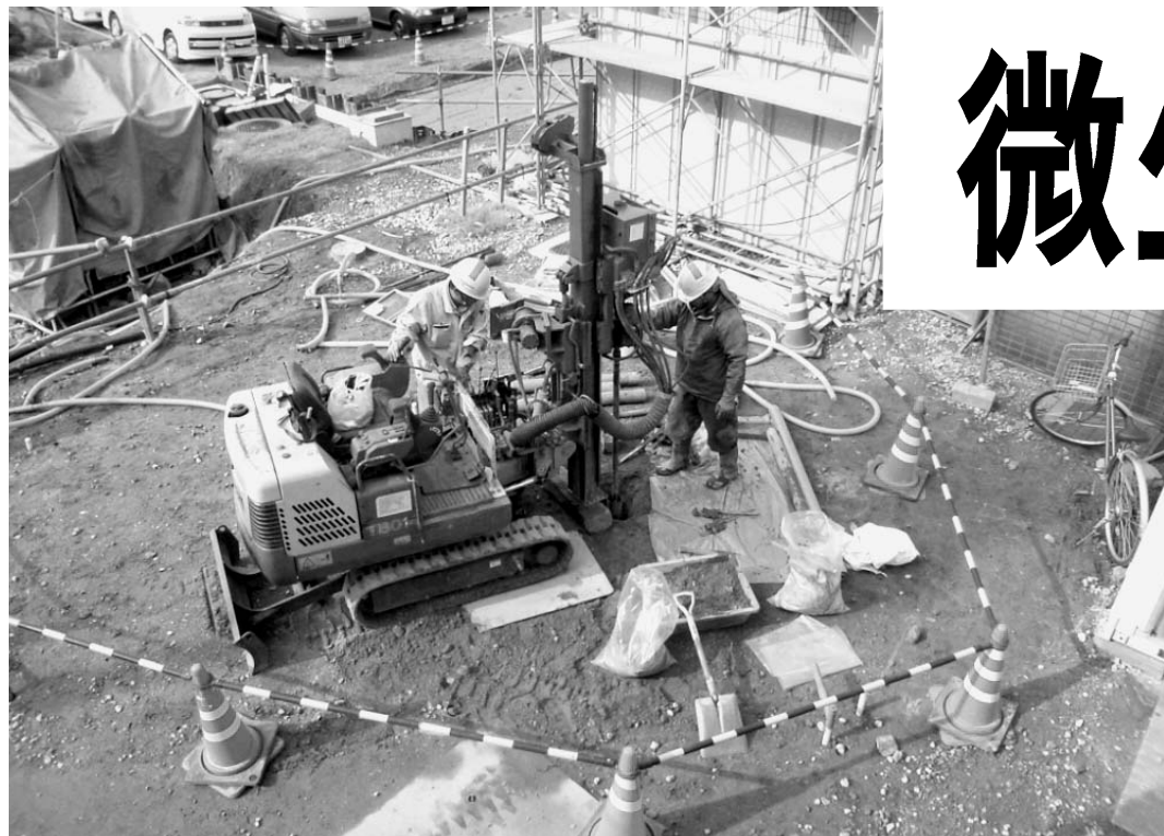
バイオレメディエーションによる油汚染土壌浄化作業
