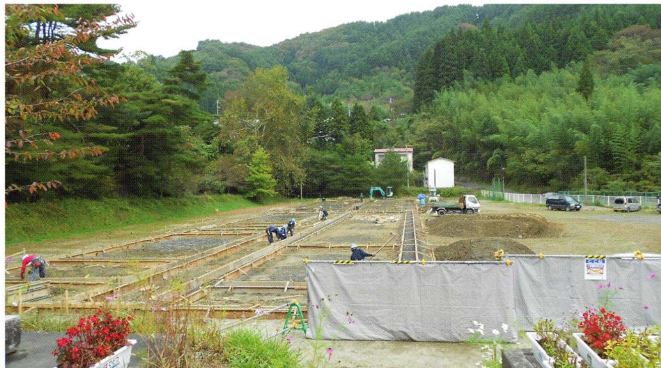
今の校舎は地震の影響で使えなくなっていました。 校庭に仮設校舎の建築がはじまりました。
