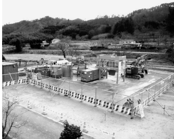
三井住友建設が設置した福島県除染技術実証事業の処理プラント（伊達市）
