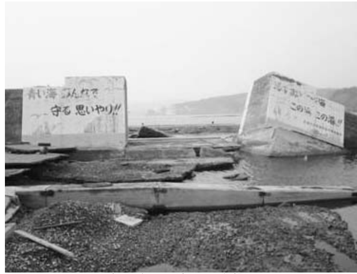
南三陸町の壊れた防潮堤
