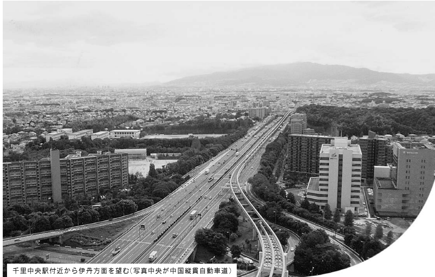
千里中央駅付近から伊丹方面を望む(写真中央が中国縦貫自動車道)
