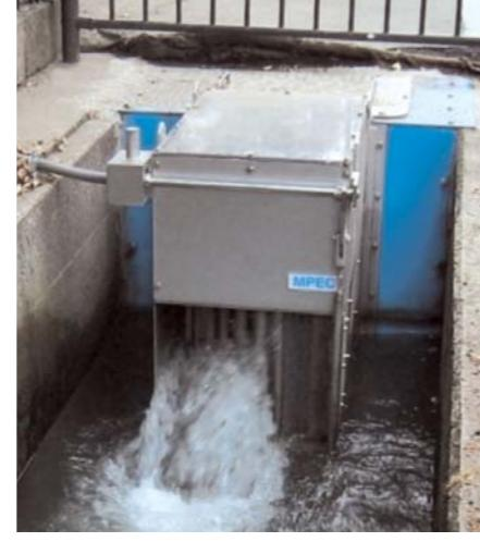
軸受がなく、水に混じる泥や砂の影響を受けにくい構造としている。
