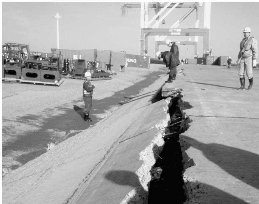
◀陥没した港の岸壁 (茨城県提供)
