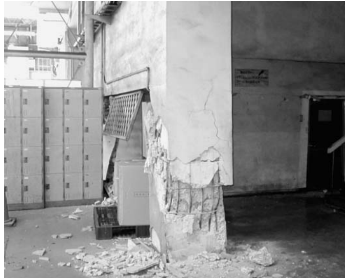
座屈した工場の柱(日立製作所水戸事業所提供)
