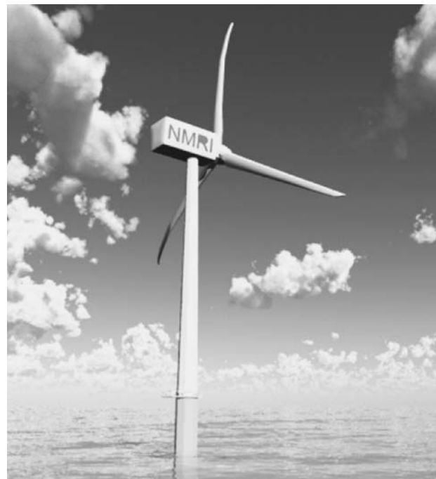
国内の浮体式洋上風力発電研究 (海上技術安全研究所提供、ダウン ウィンド形式、2 - 5 MW級、海面下 長さ77.5 - 85.4m、対象水深200m)
