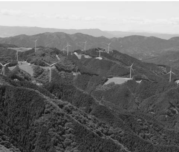
国産風車が設置された複雑地形上 ウィンドファーム (シーテック提供、 ウィンドパーク笠取、日本製 鋼所製 2 MW風車)
