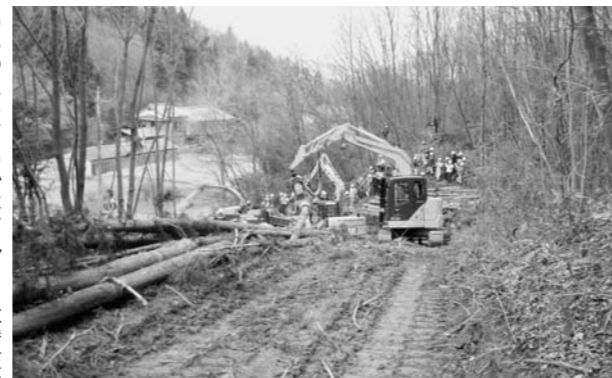
プロセッサによる造材、グラブブルでチップパーに投入、トラックで運搬といった一連のシステムが必要とされている(埼玉県秩父市)
