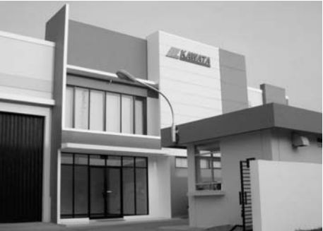
ジャカルタ新工場。近隣に土地を取得し、拡張も検討(カワタ)
