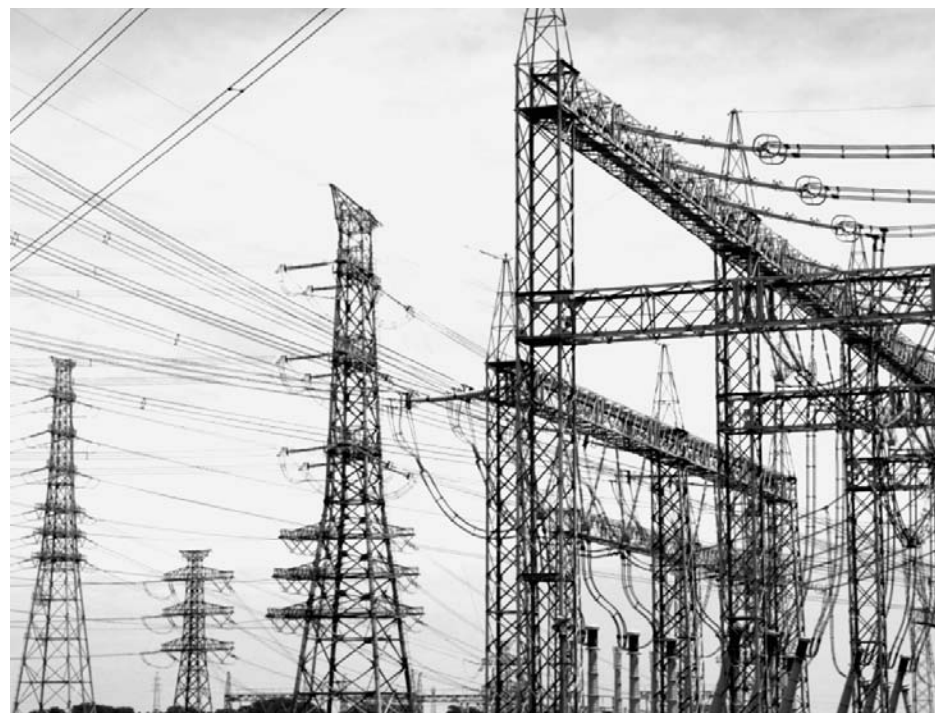
変圧器はスマートグリッドの重要な構成要素（埼玉県深谷市にある東京電力の福岡部変電所＝ブルームパーク）
