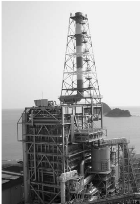
古紙や廃プラスチックの混合燃料であるRPFなどを利用する王子製紙富岡工場の新エネルギーボイラ
