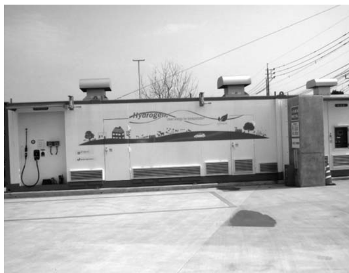
鳥栖環境開発総合センターが運用する水素ステーション
