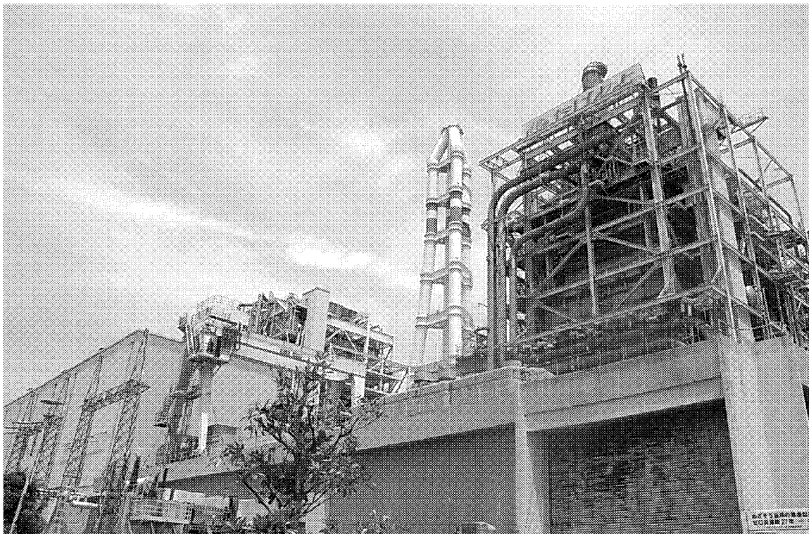
2号機と3号機が再稼働した中部電力の武豊火力発電所
