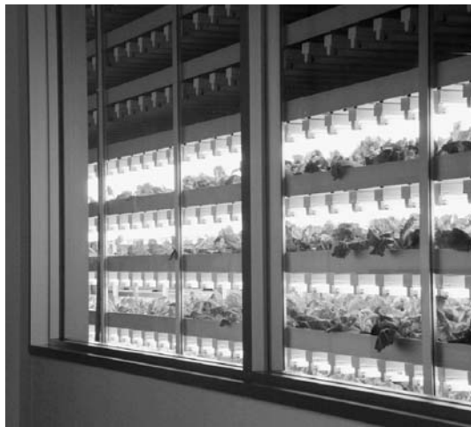
柏市内に建設された千葉大学の植物工場
