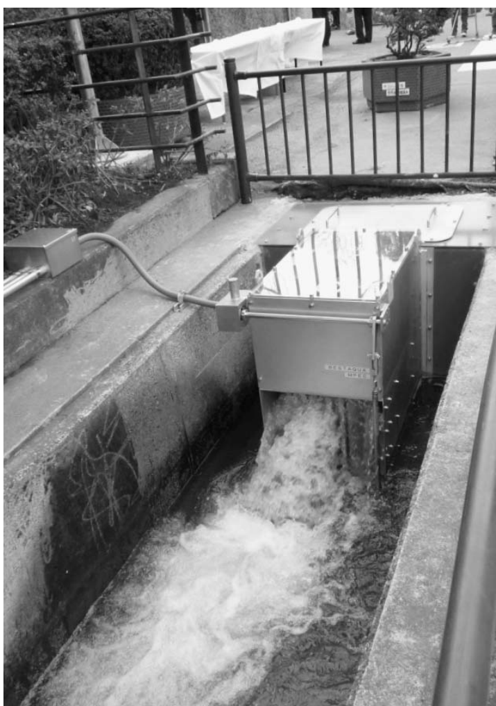
群馬県前橋市が設置した電気自動車(EV)発電用小水力発電。3月に稼働
