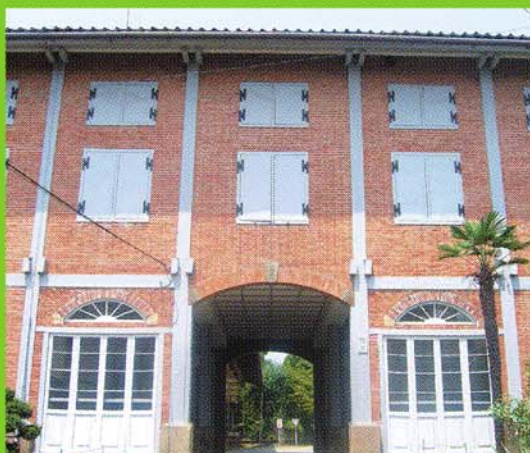
富岡製糸場内にある東館倉庫(画像提供/富岡製糸場)
